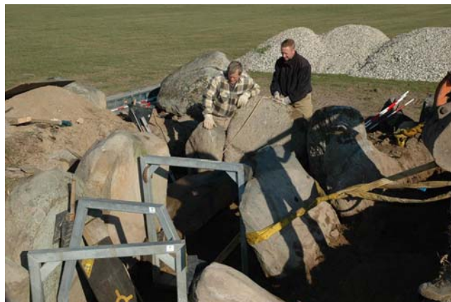
Svinø Østerhøj. Opretning af de væltede bæresten.
