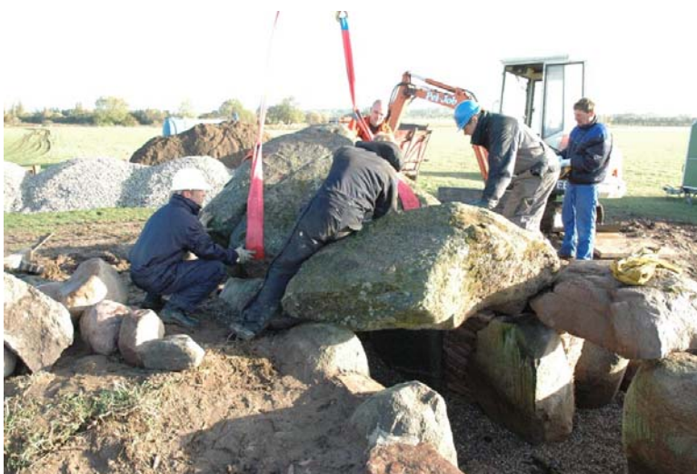
Svinø Østerhøj. Pålægning af dæksten over kammeret.
