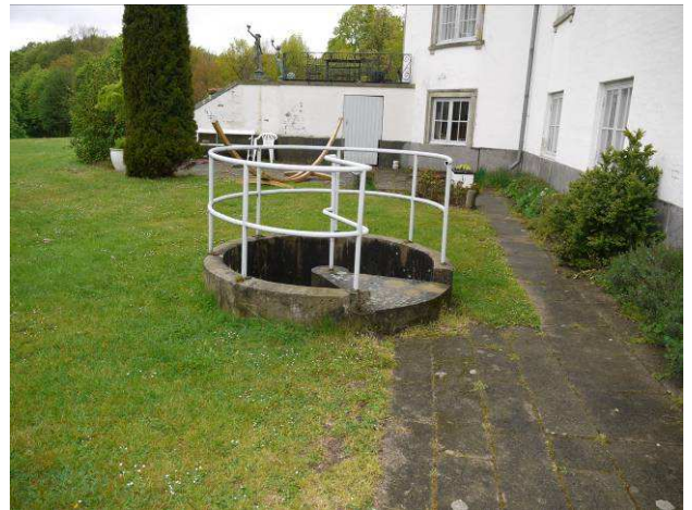
Nedgang til hvælvet kælder
