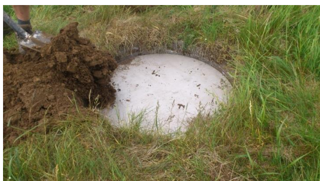
Tildækning af det nye dæksel
