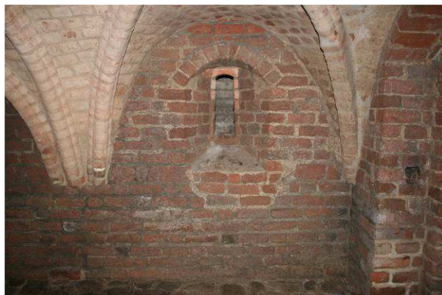
Den hvælvede kælders vestvæg med vinduesåbning
