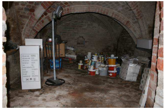
Kælderen bliver brugt som deponeringsrum. Set fra øst.
