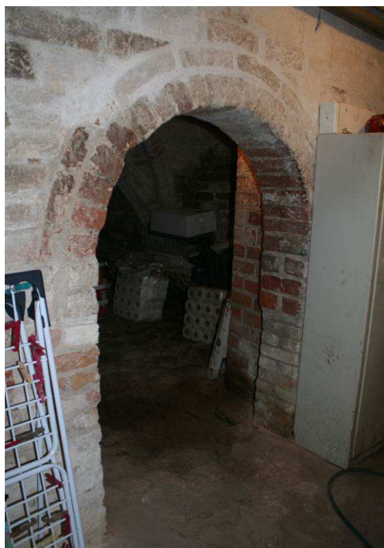
Indgang til kælderen fra et lille forrum mod øst.
