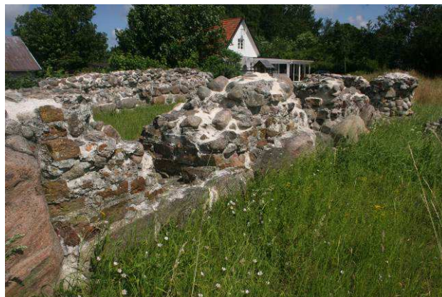
Ruinen set fra sydvest. I forgrunden sydmuren med teglmurede åbninger.
