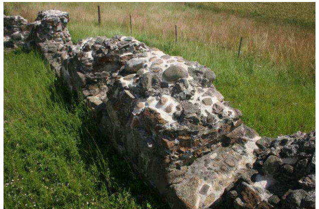
Sydturen med rester af to teglmurede lysåbninger.
