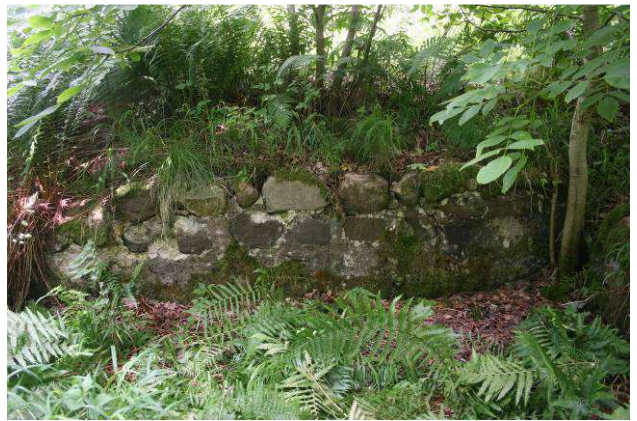
Bevaret puds på kælder murenes indvendige flader bør sikres.
