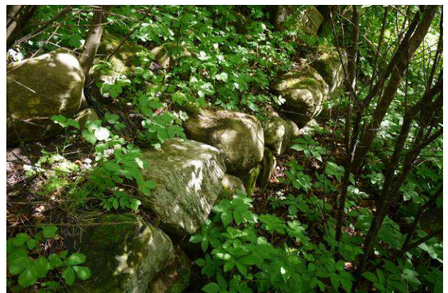
Indvendig kældermur mod øst
