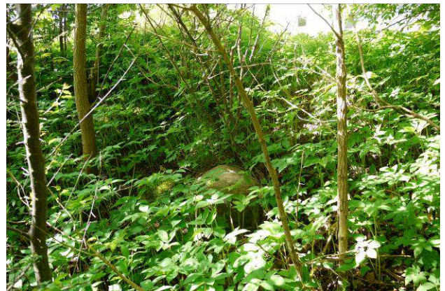
Indvendig kældermur mod nord
