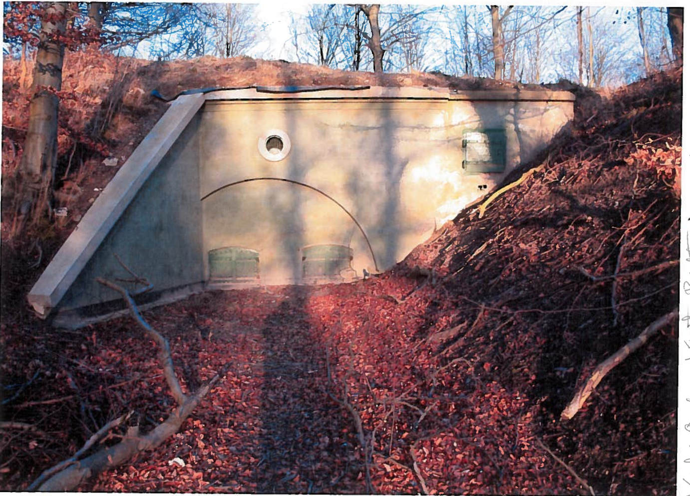
Veste Oeding Vind Batteri. Vestfacade. Foto med DMV
