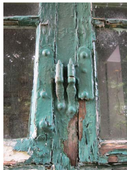
Vindueshængsler på midthængte vinduer.
