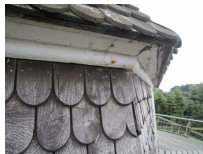
Overgangen mellem den lodrette beklædning og møllens kurvede sider er indfattet af en profileret, hvidmalet træliste.
