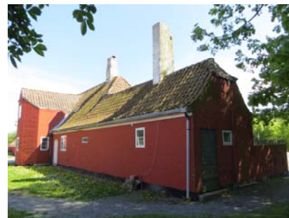
Bagsiden af stationsbygningen set fra vest.
