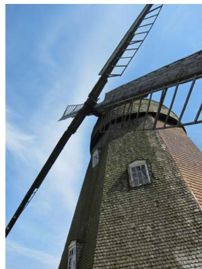
Svanemøllens vinger, der kan monteres med ensidige klapsejl.
