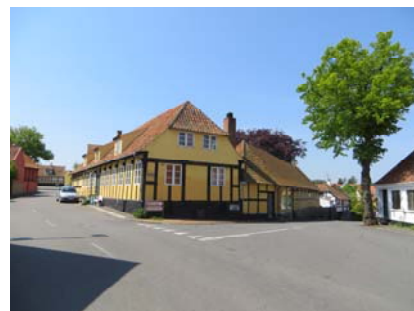
Forhuset ud mod Storegade, mellembygningen samt sidehuset langs Vigebakken.
