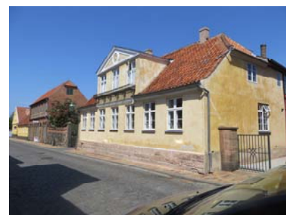
Det nordøstre forhus er i dag bolig.
