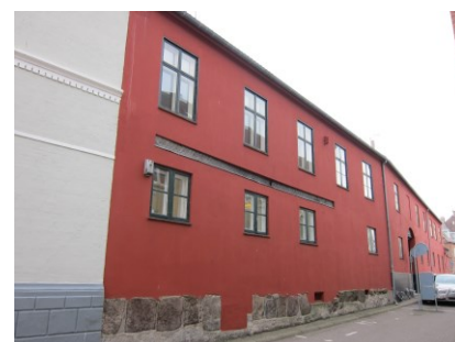
Vestre sidehus med kampestensokkel og en synlig overgangsfod, der stammer fra en ældre bindingsværkskonstruktion.
