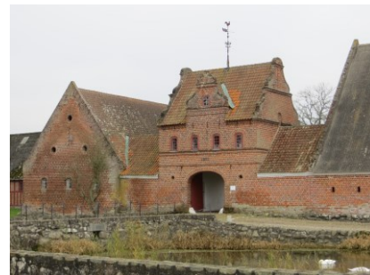
Portbygningen ind til ladegårdsholmen.
