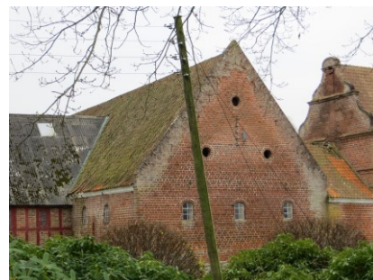
Nordre staldbygningens vestre gavl, set fra vejen.
