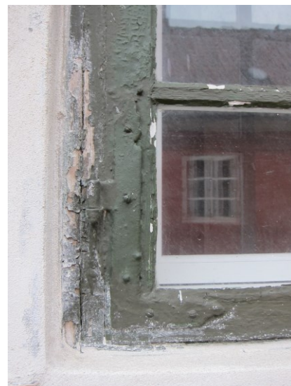
Ældre hjørnebånd på facadens vinduer.
