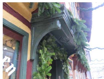
Fordakningen over døren i facaden.
