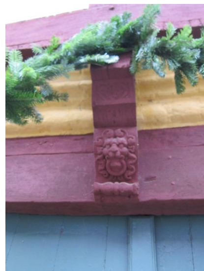
En af de udskårne knægte i facaden.
