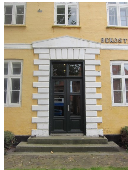
En indgangsdør med kvaderpudset portal.
