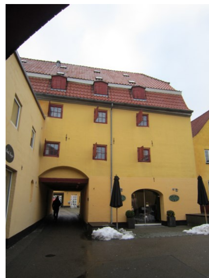
Pakhuset, set fra syd med de åbentstående revleluger.
