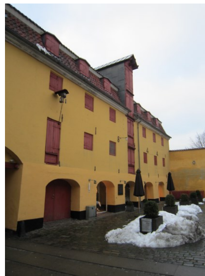
Den høje hejsekvist gør det muligt at tage varer ind på første, anden, tredje etage samt hanebåndsetagen.
