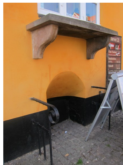
En af de tilmurede kældernedgange på gadesiden.
