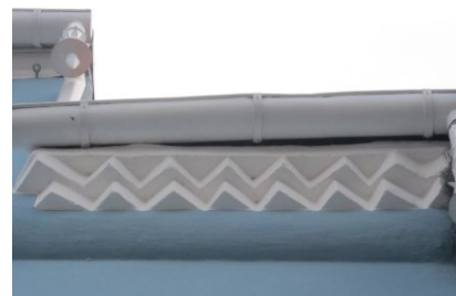
Den dobbelte savsnitgesims af munkesten på facaden.
