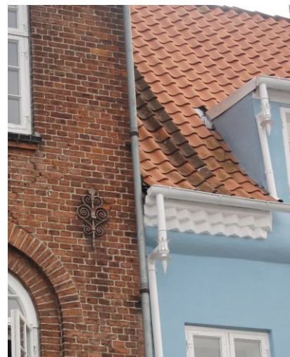
Drueknæ på facadens nedløbsrør.
