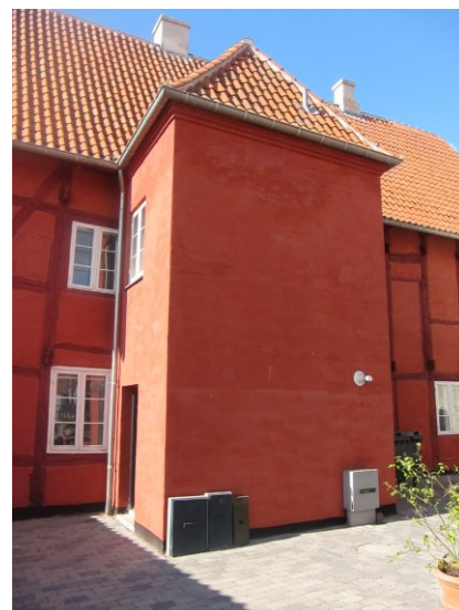
Gårdsiden med det grundmurede trappehus fra 1945.
