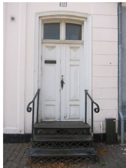
Indgangsdør med trappe af støbejern foran.
