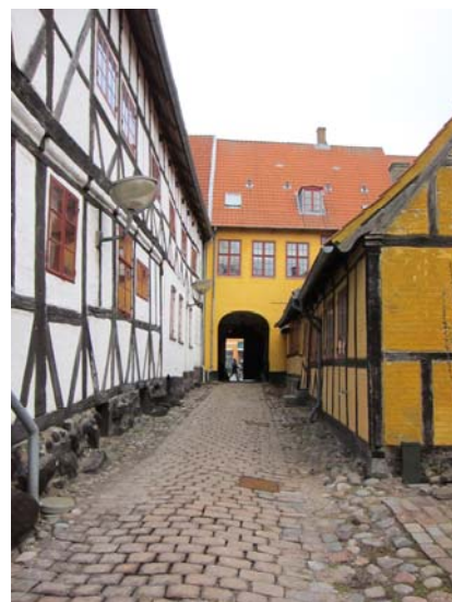
Porten i forhusets gadeside og det ene af de to gulvklædede bindingsværkssidehuse.
