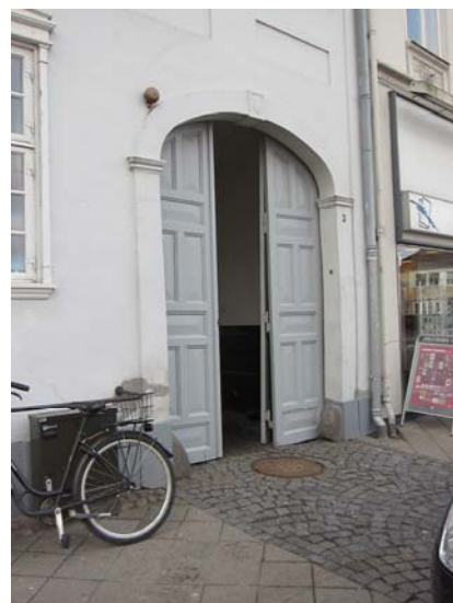
Porten i facaden.
