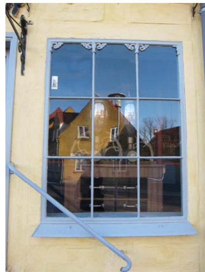
Butikkens støbejerns vinduer.
