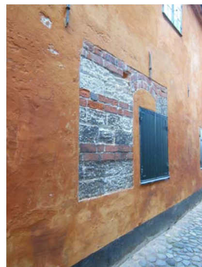
Sidehusets bæltmuring med to skifter kridtsen og to skifter munkesten, samt et tilmuret vindue med prydkifte over det fladbuede stik.
