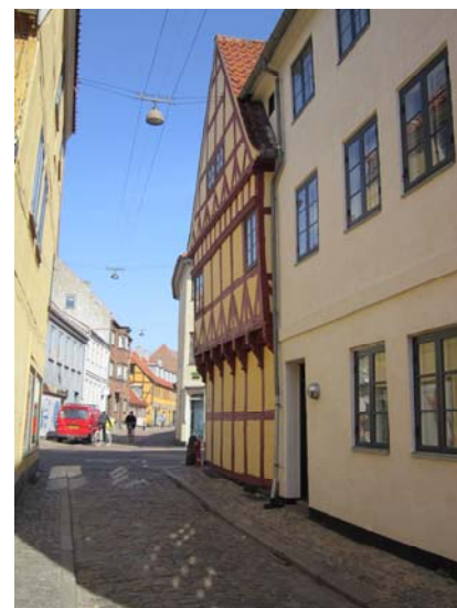
Sidehuset står som grundmur mod gaden, men er i bindingsværk mod gården. Her ses også forhusets markante, udkragede overetage og gavl.
