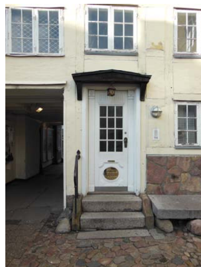
Forhusets gårdside med den festlige dør, som nok stammer fra indretningen til apotek i 1913. Vinduerne med de seksrudede rammer er bevaret fra opførelsen.
