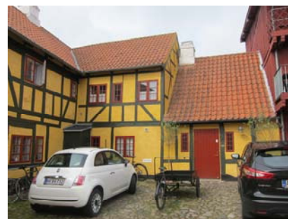
Gårdsidens bindingsværk med den varme farvesætning, der understøtter det stemningsfulde gårdmiljø.
