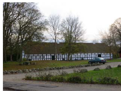
Stuehuset set fra nord.
