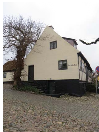
Gavlen og gårdsiden er grundmurede.
