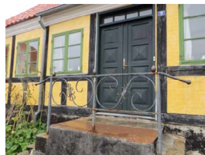
Hoveddøren med toløbstrappen og støbejernsværn.
