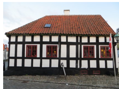
Facaden mod Nedergade.
