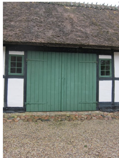
Revleport og små vinduesåbninger i den østlige udlænge.
