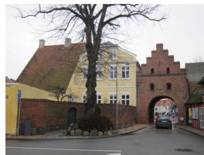
Forhusets vestgavl er bygget sammen med både byporten og vestre sidehus. Foran den krumme havemur ses resterne af den tidligere vendeplads foran Vesterport.
