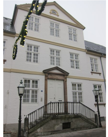
Gavlkvisten med det markante indgangsparti nedenunder.
