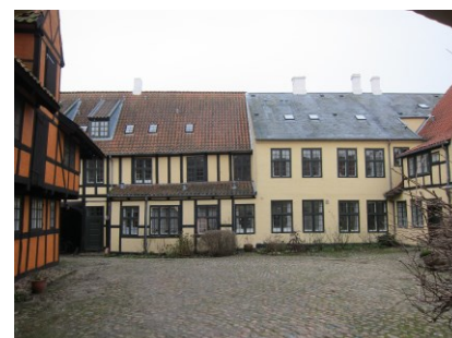
Østre sidehus, forhusets bagside og vestre sidehus set igennem baghusets brede portåbning.
