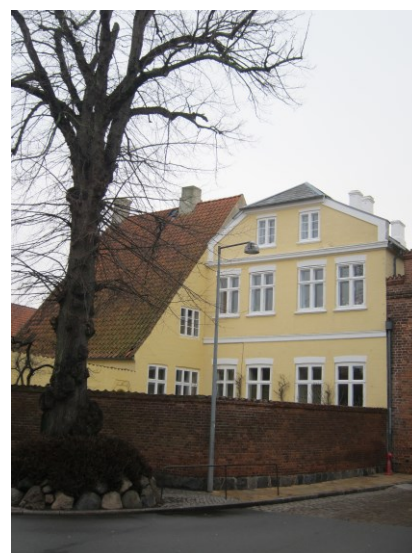
Vestre sidehus og forhusets vestvendte gavlfremtræder.
