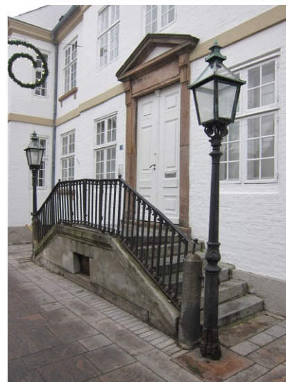
Indgangspartiet med den toløbende trappe foran.
