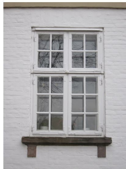
Enkelte vinduer er forsynet med konsolbårne sålbænke i sandsten.
