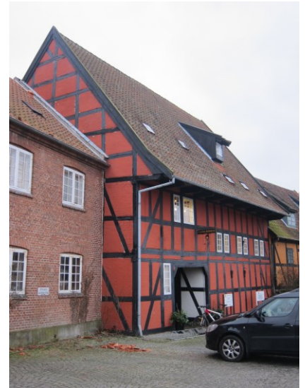
Østgavlen i bindingsværk er delvist synlig – bemærk det store tagudhæng.
