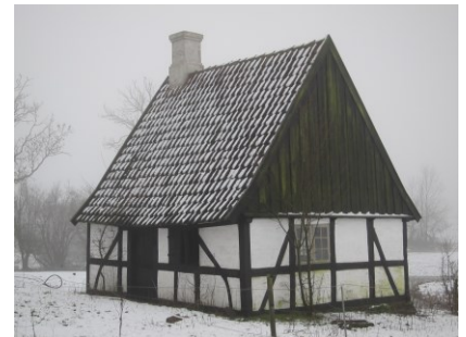
Smedjen, der ligger lidt afsides fra resten af gårdanlægget, har karakteristiske, krumvoksede skræstivere.
