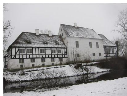
Hovedbygningen bestående af Stenhuset og sidefløje.
