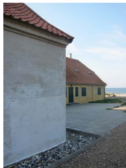
Her ses forskydningen imellem de to bygningskroppe tydeligt.
