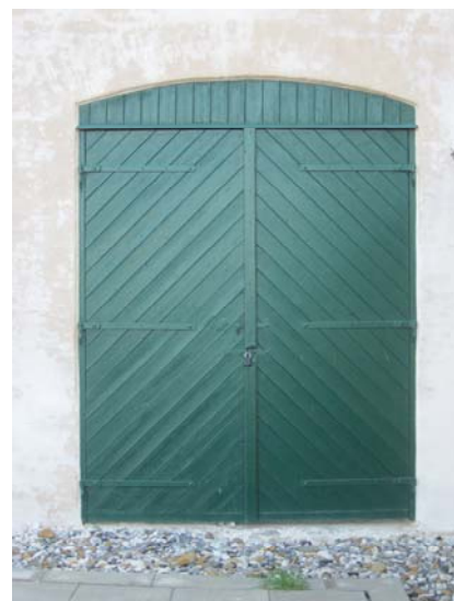
Porten i bådehusets vestgavl.
