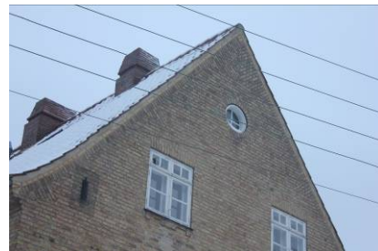
Gafl med strømskifter og rundt vindue øverst. Det bemærkes ved murkronen at taget er omlagt og isoleret.
