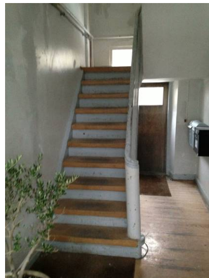
Trapperummet med ældre trappe.
