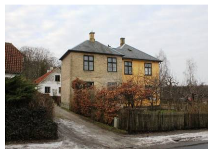
Lageret med tilbygning set fra vejen.
