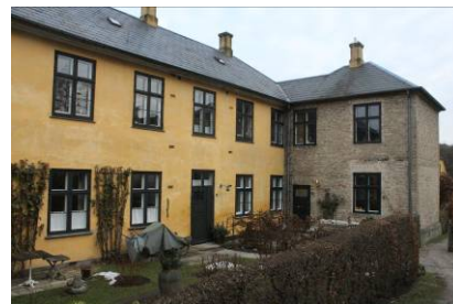
Gårdrummet på bagsiden.
