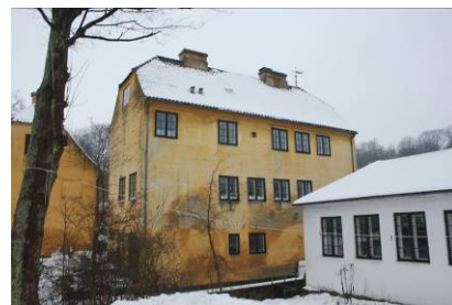
Bagsiden mod stemmeværket.
