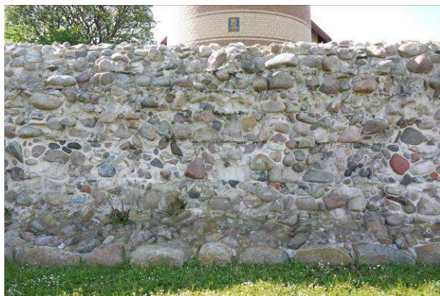
Nordsiden med byggeskel i murkernen
